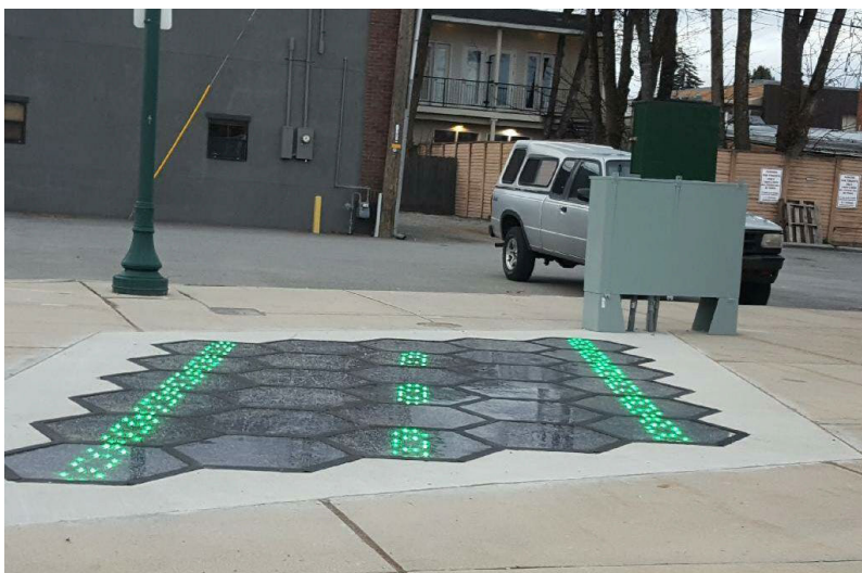
Рис. 2. Участок тротуара, где впервые были использованы солнечные панели компании Solar Roadways Incorporated
