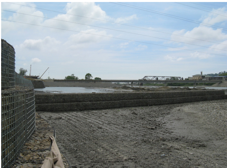
Рис. 6. Участок берегоукрепления в г. Сочи
