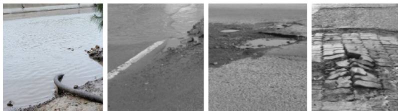
Рис. 2. Негативные последствия ненадлежащего водоотведения [6, 8]
