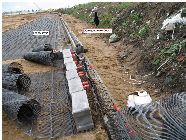
Рис. 5. Основные составные части армированных стен
